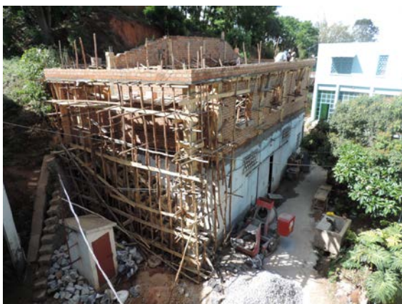
Chantier extension Atelier. Novembre 2015
