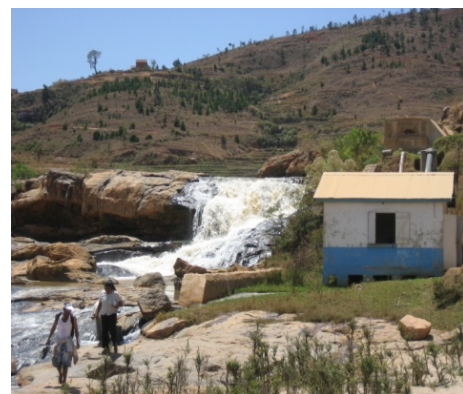
La picocentrale hydroélectrique d'Andretsemboka
